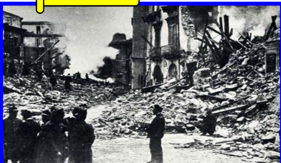
TERREMOTO DI NICASTRO (CZ) 8 SETTEMBRE 1905 h 1.43
